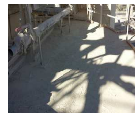
Limpieza sobre silo de cal / 2 personas
