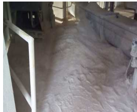
Sobre silo de molienda Planta Cal / 2 personas
