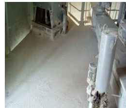
Sobre silo de molienda Planta Cal / 2 personas
