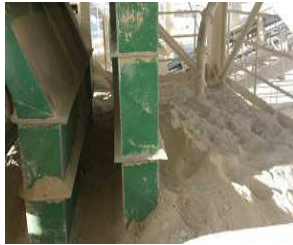
Limpeza en área horneado correa 405 / Planta de Cal/ 2 Personas
