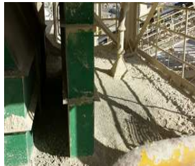
Limpeza en area horneado correa 405 / Planta de Cal/ 2 Personas
