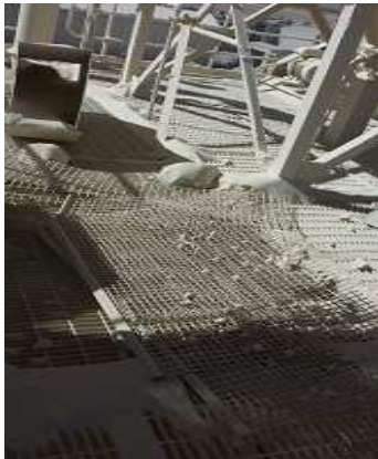
Condicion Sub Estandar , mallas encontradas en pasillos superior correspondiente al harnero 451 Planta de Cal
