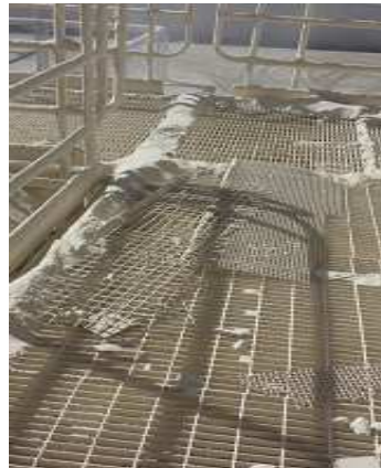
Condicion Sub Estandar , mallas encontradas en pasillos superior correspondiente al harnero 451 Planta de Cal
