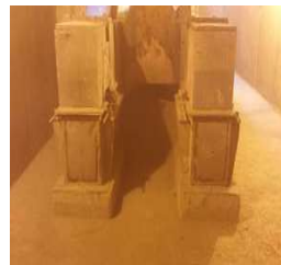
Sector cajones UJ , horno Clinker/ Planta de Cemento/ 4 Personas
