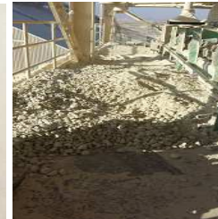
Limpeza Pasillo correa 702/ Planta de Cal/ 2 Personas
