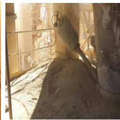
Limpeza material con temperatura torre ciclones horno clinker/ Planta de Cemento/ 3 Personas
