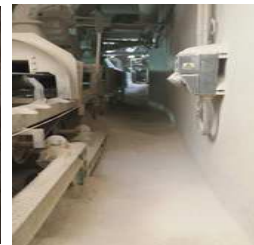
Limpeza sector cajones UJ , horno Clinker/ Planta de Cemento/ 4 Personas
